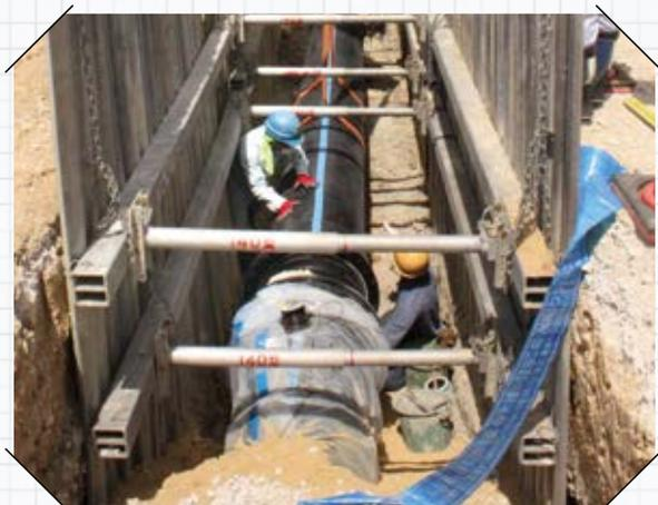
配水管布設替工事(φ600mm)の様子
